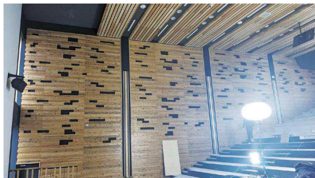
写真2 工事中の大講堂の内部(壁には東京オリンピックで使用した山形県産のレガシー木材が貼られている)
